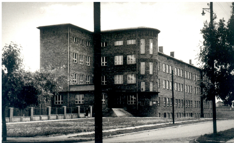
Budynek I LO im. S. Żeromskiego w Zawierciu – wygląd siedziby szkoły w latach 60-tych XX wieku (fotografia archiwalna) 8
